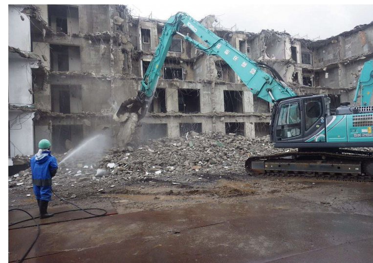
建物上屋解体状況イメージ
