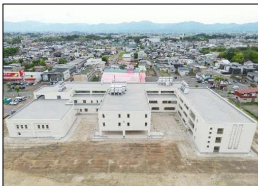
建物外観（西面）
