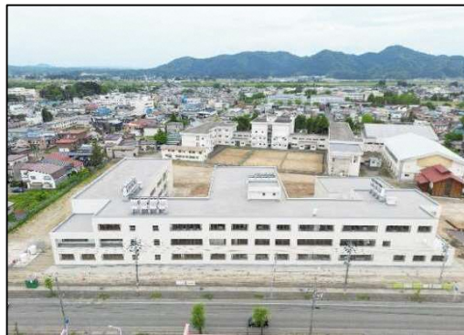
建物外観（東面）
