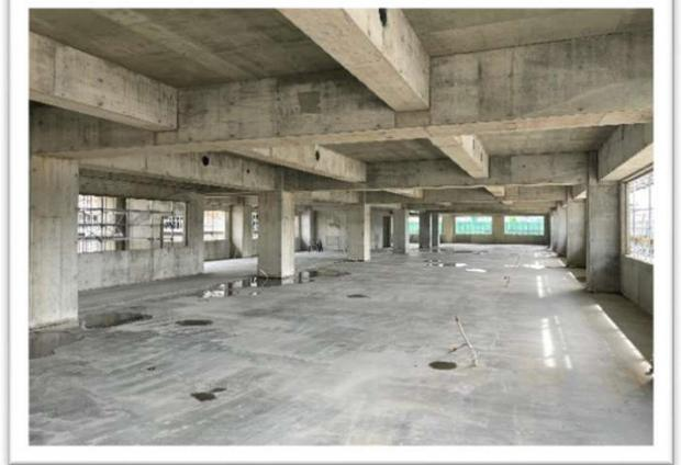
⑥建物内部の様子（型枠・支保工解体完了）
