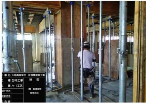
⑤型枠工事（1階型枠解体状況）
