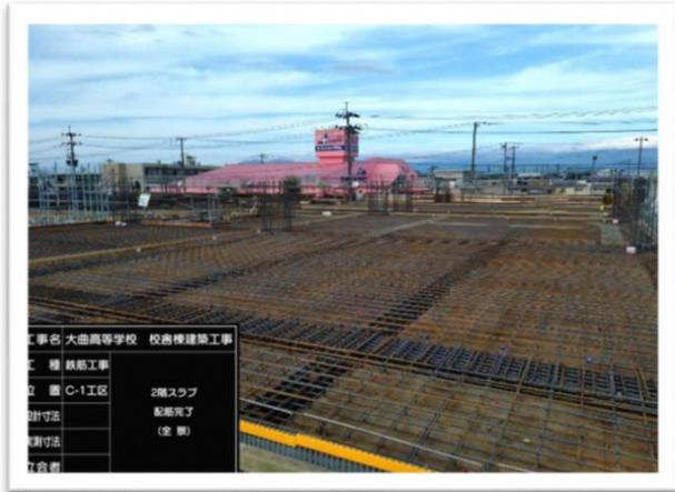
⑤鉄筋工事（スラブ配筋完了）
