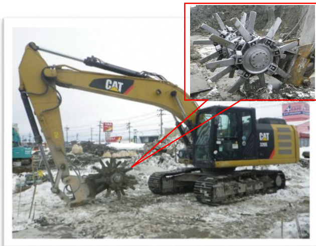
※重機に攪拌用の特殊なアタッチメントを装着しています。
