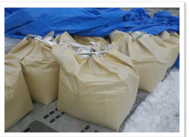
④古紙の他にセメント系固化材も混合します。
