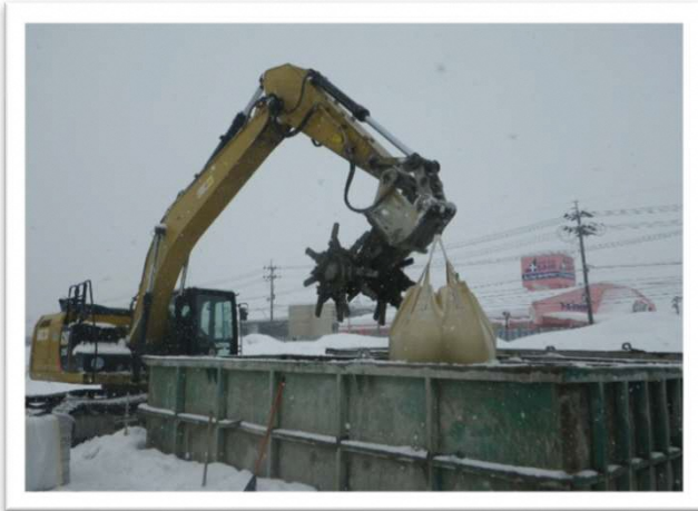
⑤古紙を投入攪拌後、固化材を投入します。
