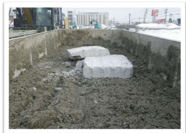
②古紙を添加・混合して汚泥に含まれた水分を吸水します。
