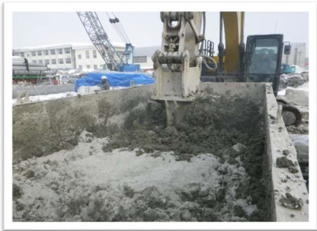
⑥重機を使用して均一に攪拌していきます。
